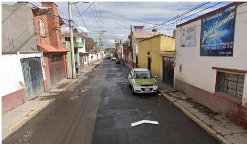
Figura 4. Situación actual de la Av. Jesús Reyes Heróles en el tramo de conflicto.
