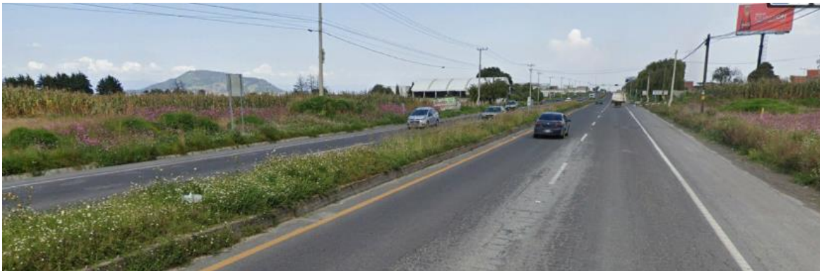
Figura 2. Situación actual de la carretera Toluca – Ciudad Altamirano
