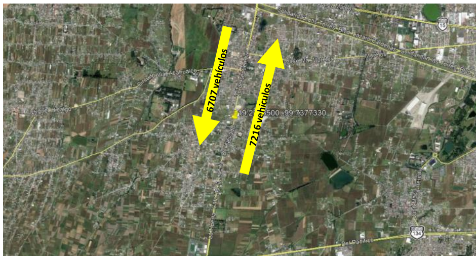
Figura 13. TDPa en Avenida del Nevado (Estación AA-05)
